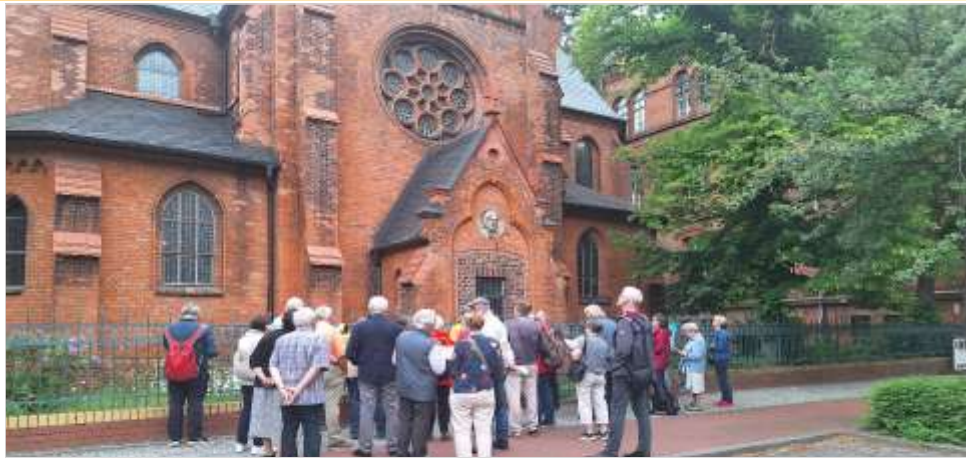
Ansicht von der Schicklerstraße an ehemaliger seitlicher Eingangstür Text und Foto: EZ
